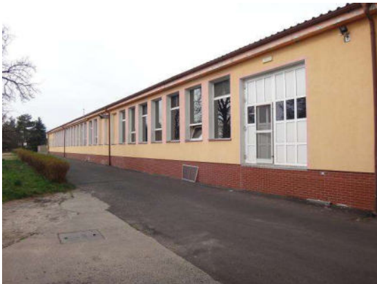
hlavní výrobní objekt
