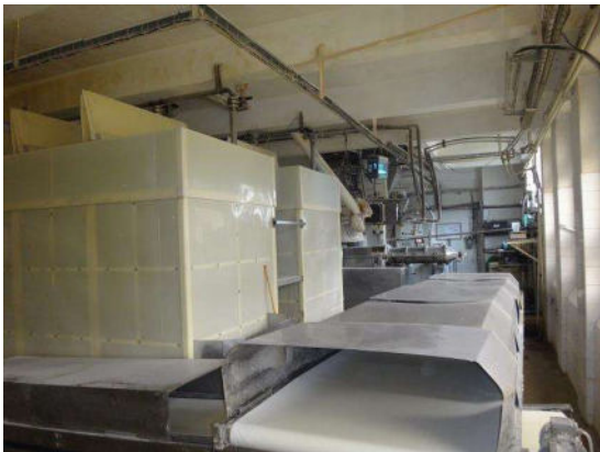
hlavní výrobní objekt
