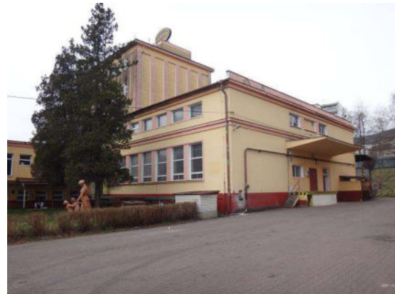
hlavní výrobní objekt
